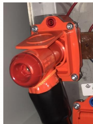
Embbase à visser M12 EV400A avec prise de potentiel 4mm
