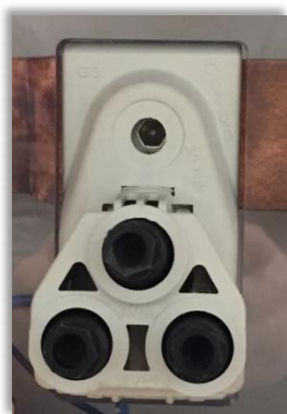
Bornes à perforation d'isolant pour câble cuivre rigide de 10 à 25mm 2 et Alu rigide de 16 à 35mm 2 , Couple de serrage de 9Nm
